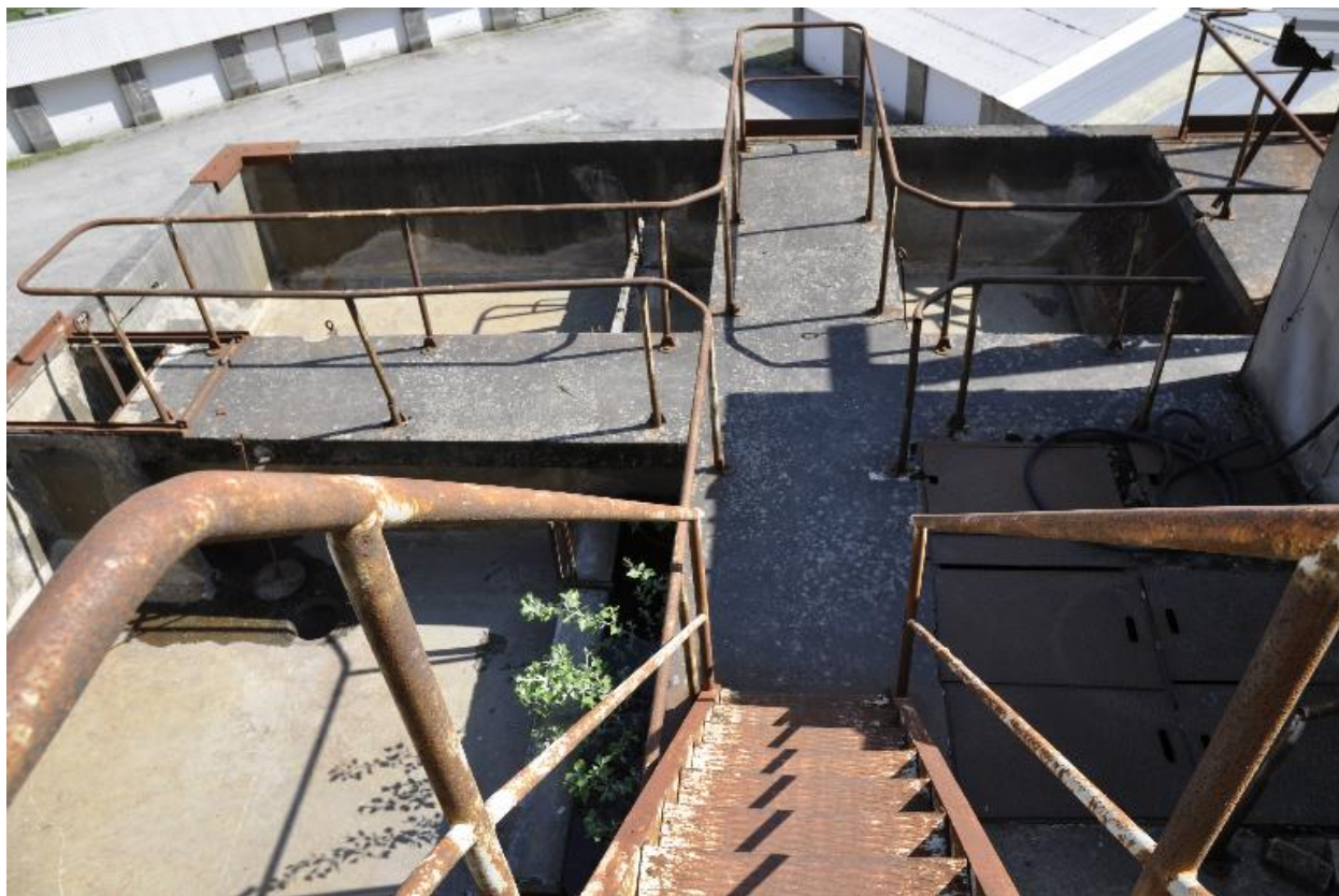
Vue des installations du canal et des bassins
