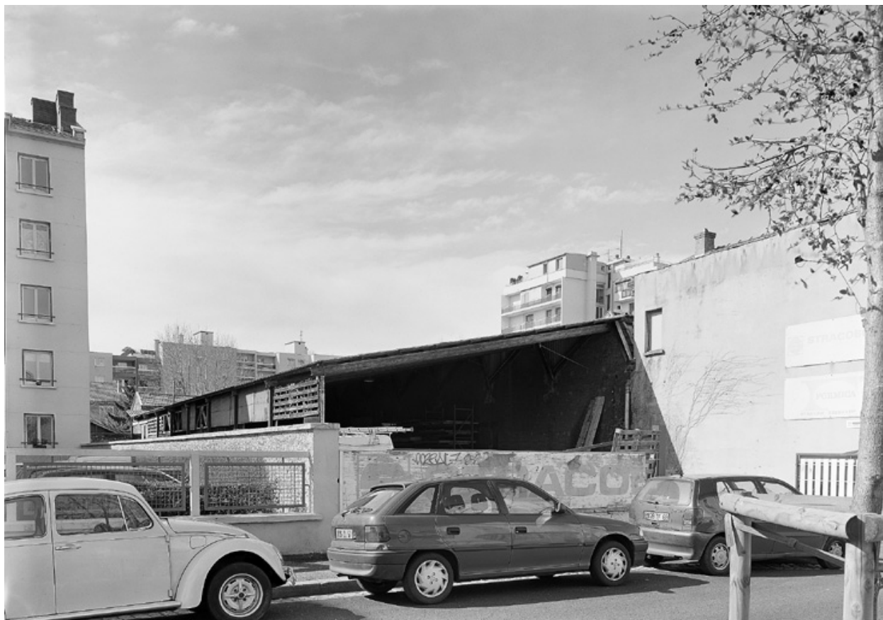
Vue sud-ouest du site
