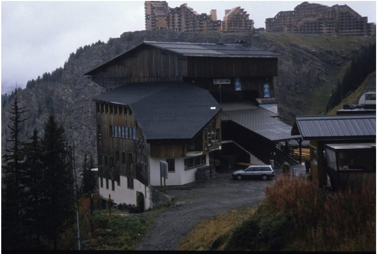
Vue d'ensemble depuis le sud-est. Photogr. 1989
