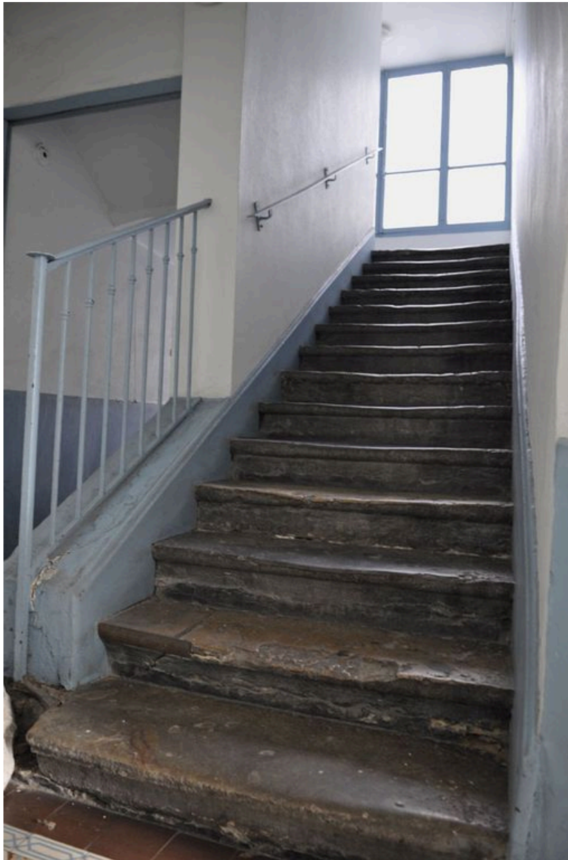
Première volée de l'escalier
