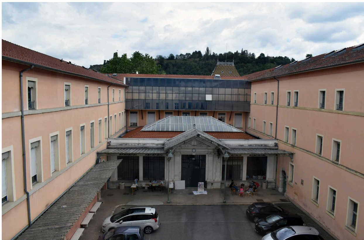
Cour 2 : autre vue d'ensemble depuis le sud
