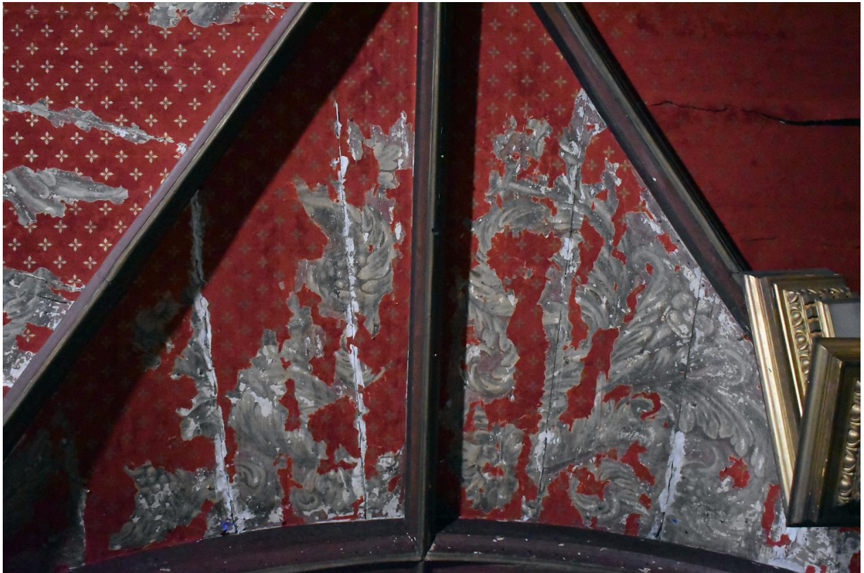
Chapelle Saint-Joseph, voûte : décor peint avec décor sous-jacent du 17e s.
