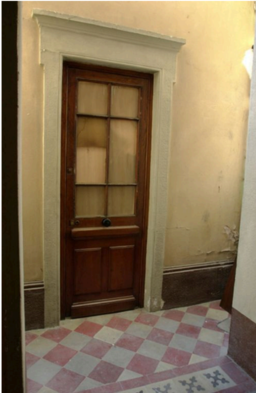
Entrée de la conciergerie au niveau du 1er repos de l'escalier
