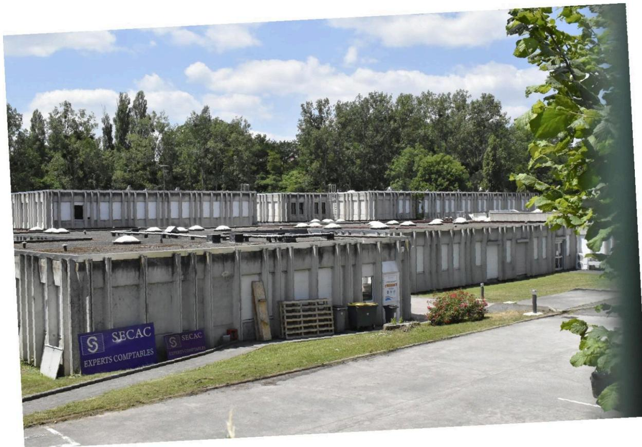
Vue depuis la rue Ernest-Montuses sur les bâtiments en rez-de-chaussée des ateliers (d'après le plan-masse de P. Lagneau). L'éclairage des ateliers provient en partie zénithalement des dômes en plexiglas.
