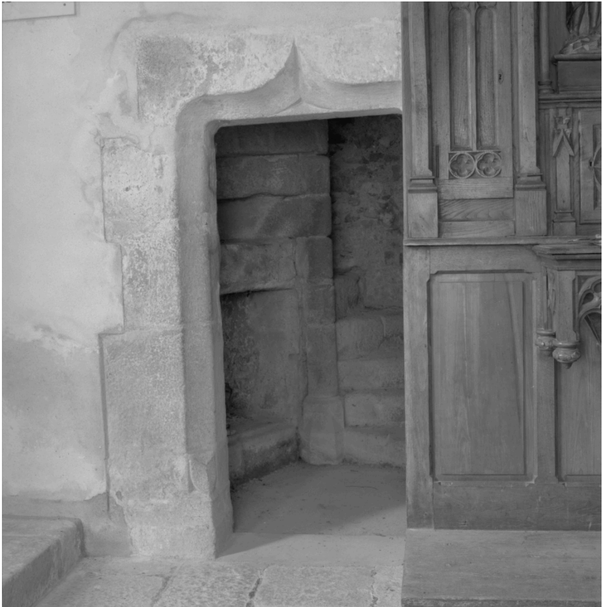
Vue intérieure, détail de la porte en accolade du clocher.
