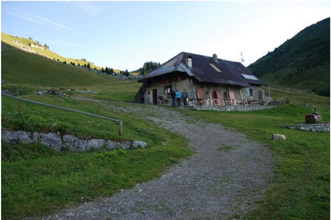
Vue de trois-quarts du bâtiment d'exploitation.
