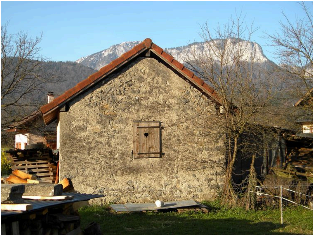
Vue de la façade arrière.
