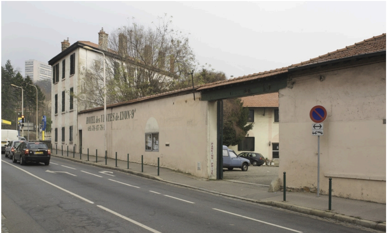
Vue d'ensemble sud
