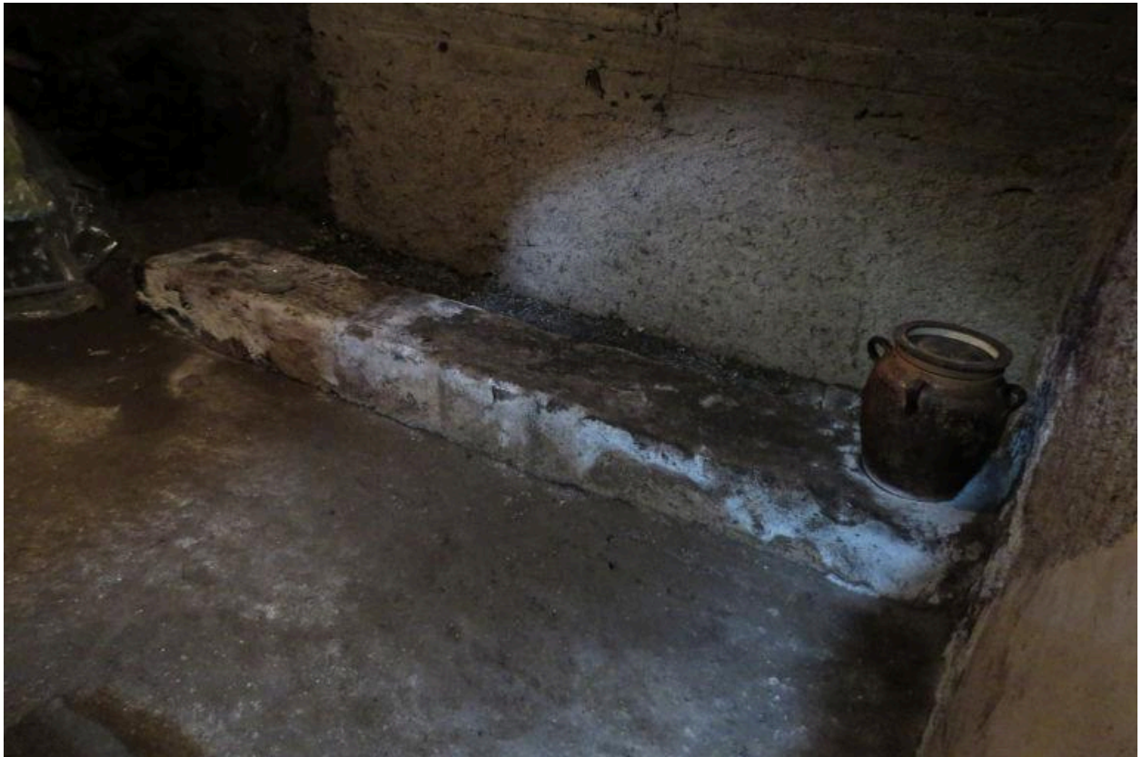
Vue intérieure : chai en sous-sol
