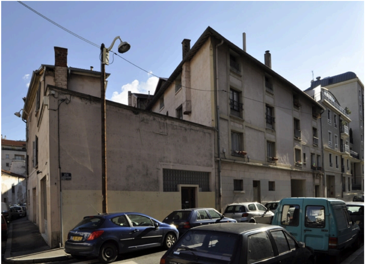
Vue générale ouest, angle rue Renan rue d'Anvers
