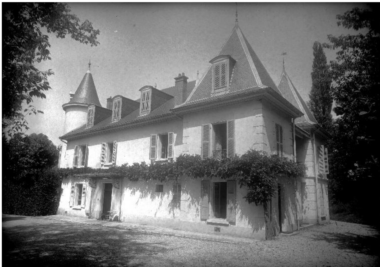
Vue de trois-quart, depuis le sud-est, vers 1930
