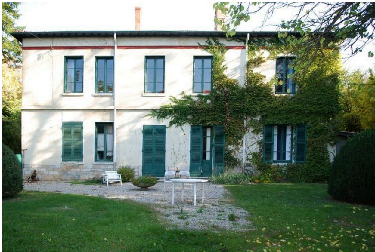
Bâtiment 225, façade postérieure
