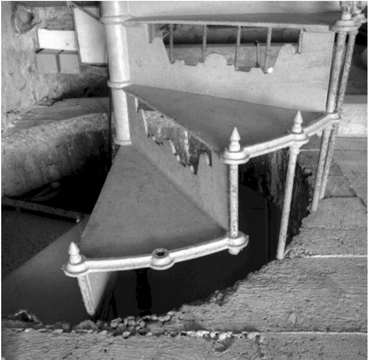
Cave nord, détail de l'escalier en fonte de fer
