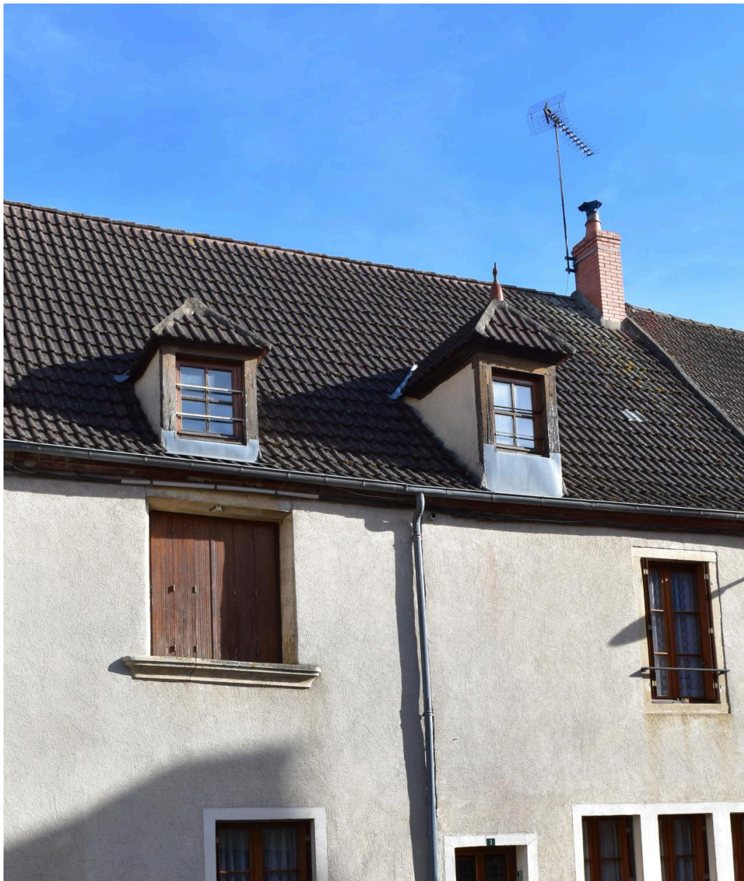
Façade du n°3 rue de Bourbon (parcelle cadastrale B01 : 108), détail de la baie du 1 er étage présentant des moulurations et un départ de meneau sur son encadrement et l'appui datables de la limite des 15 e et 16 e siècles.
