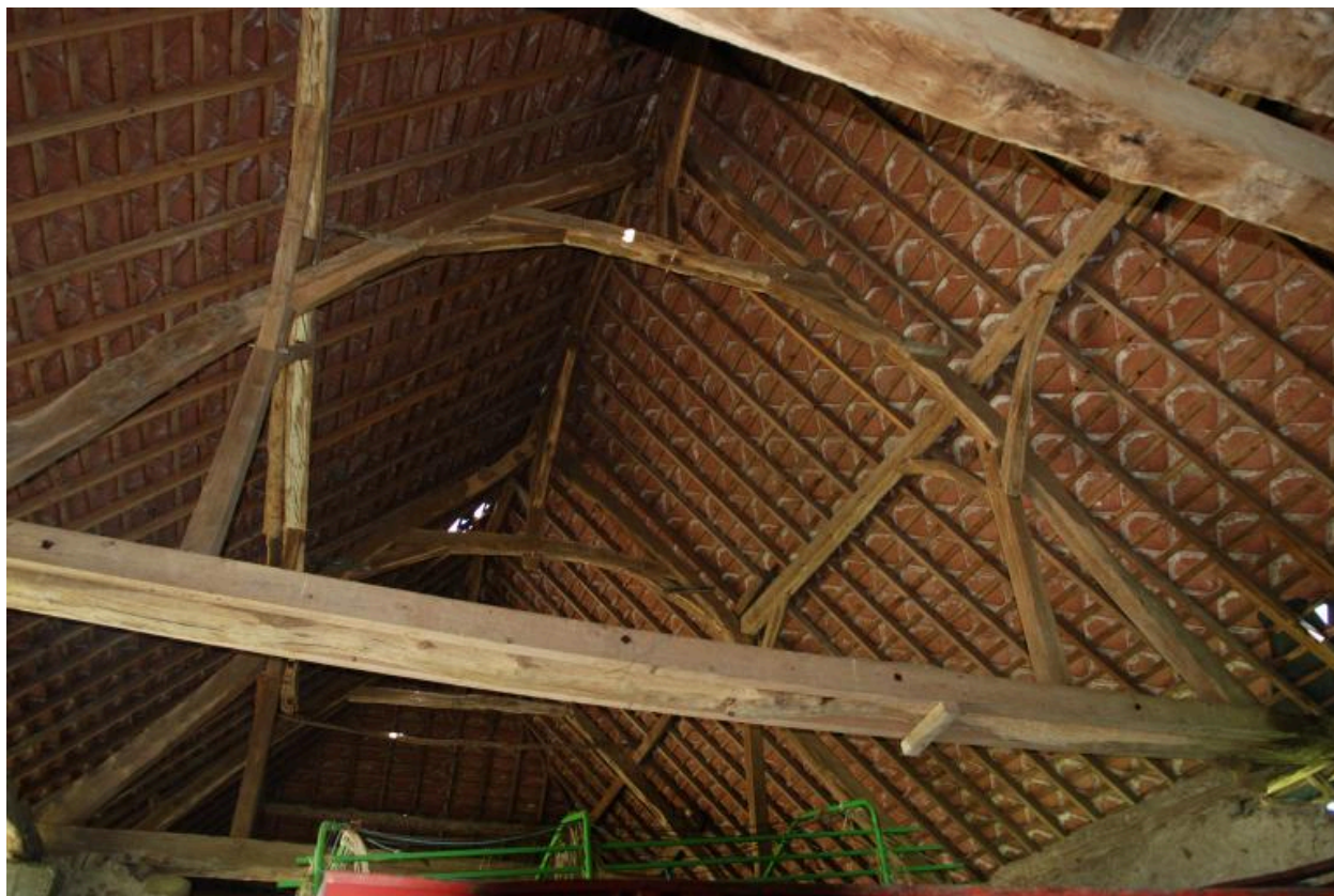
Charpente de la grange-étable.
