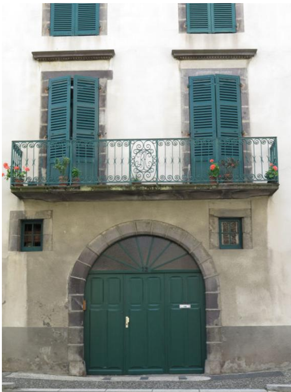
Vue partielle de la façade principale
