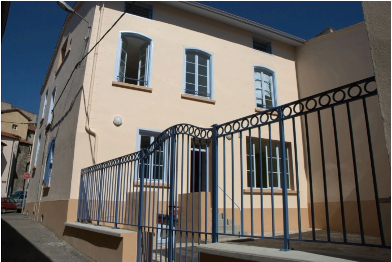
Îlot 2. Saint-Jean (rue) 40 / Saint-Jean (traversière) 1 / Roanne (rue de) 17. Vue générale du second corps de bâtiment de la maison sur la traversière Saint-Jean.
