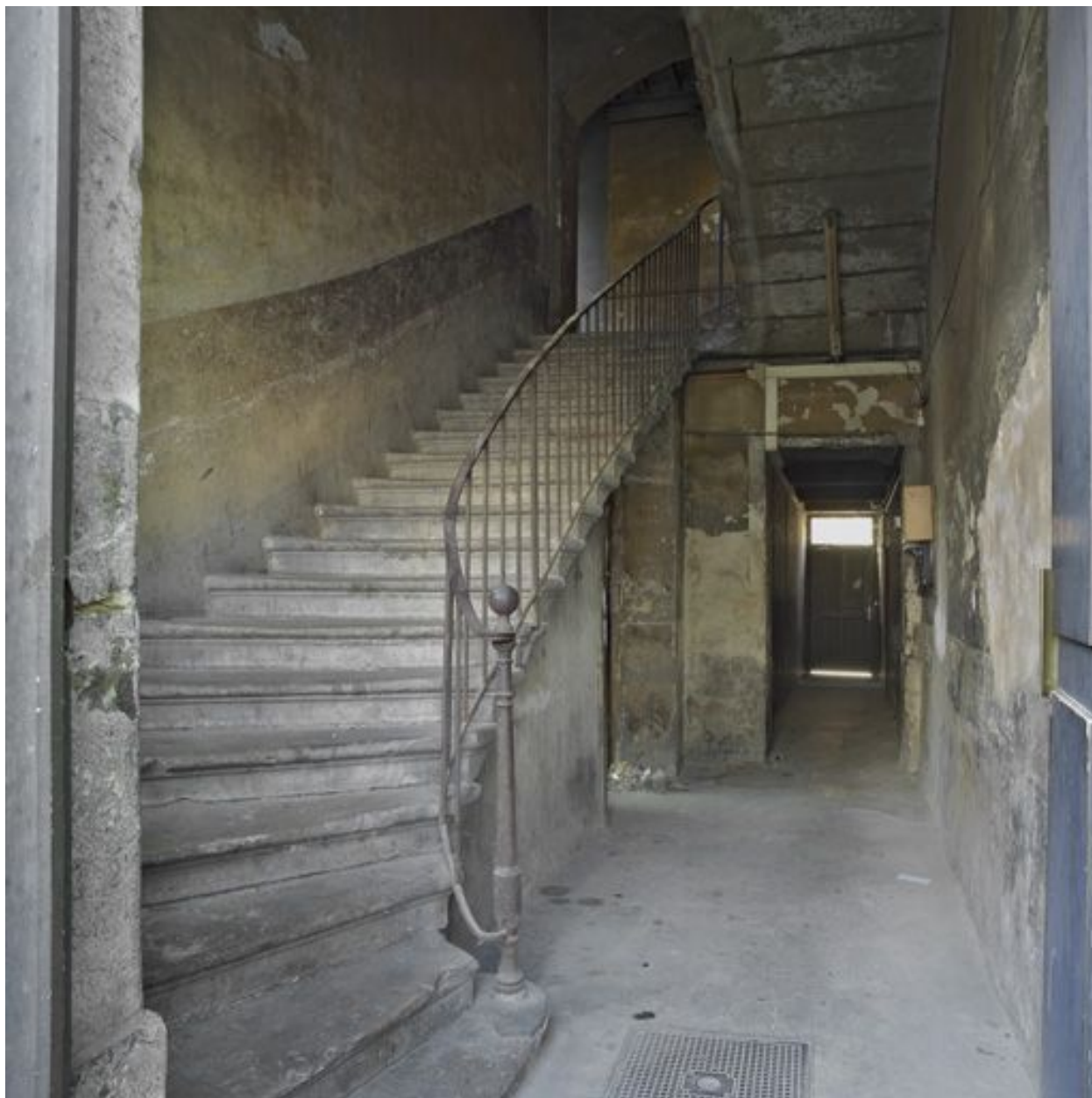
Vue de la cage d'escalier
