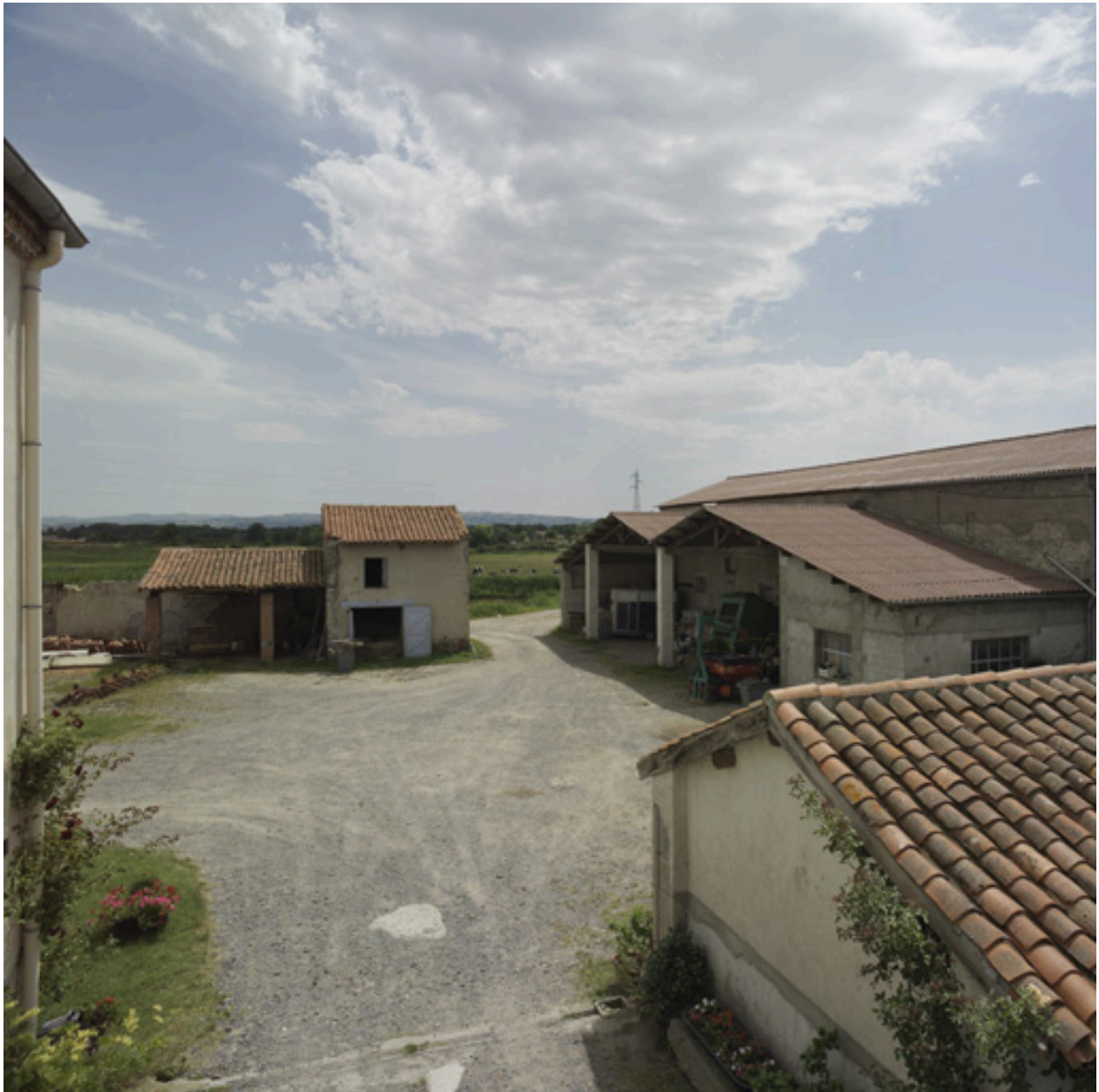
Vue d'ensemble intérieure de la cour : côtés est et sud.
