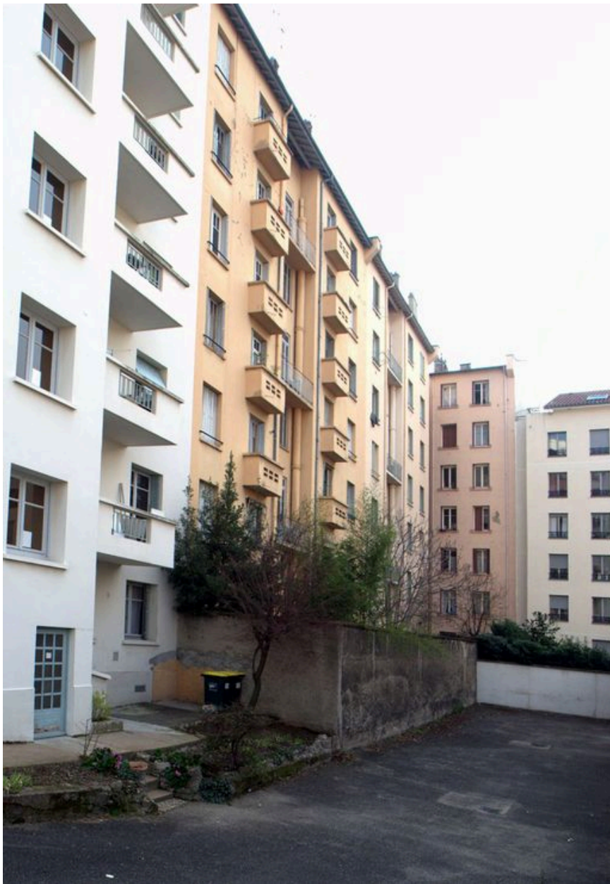
Elévation postérieure depuis le nord
