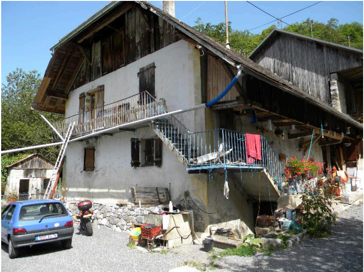
Vue du mur pignon de la ferme.
