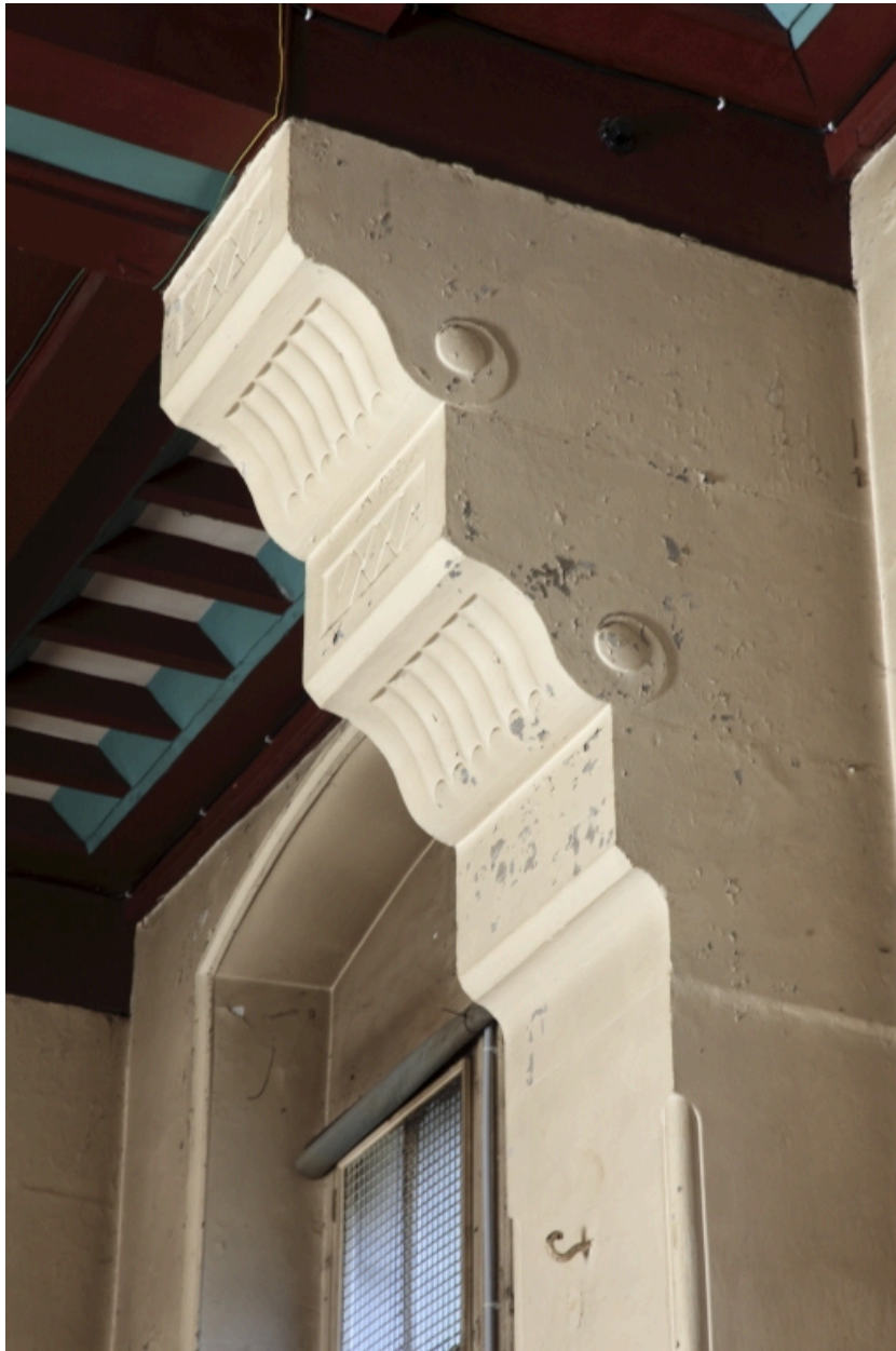
Gymnase. Détail d'un pilastre.
