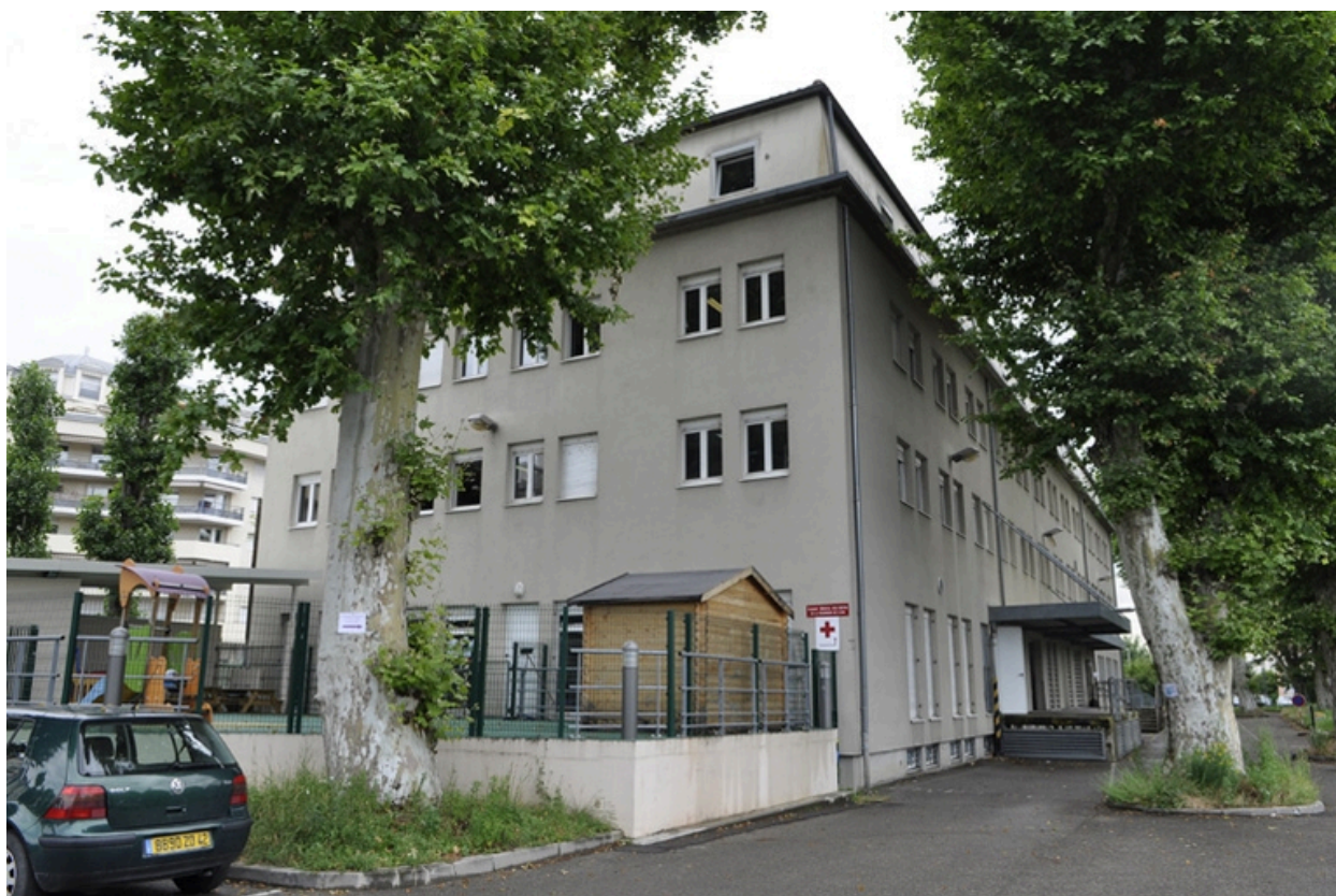
Infirmierie. Pignon nord.
