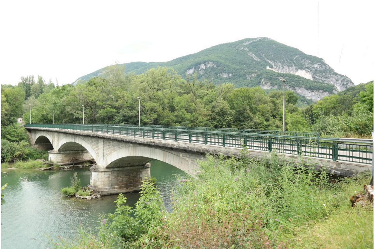
Pont du Fier. Vue de la face aval avec Montagne des Princes
