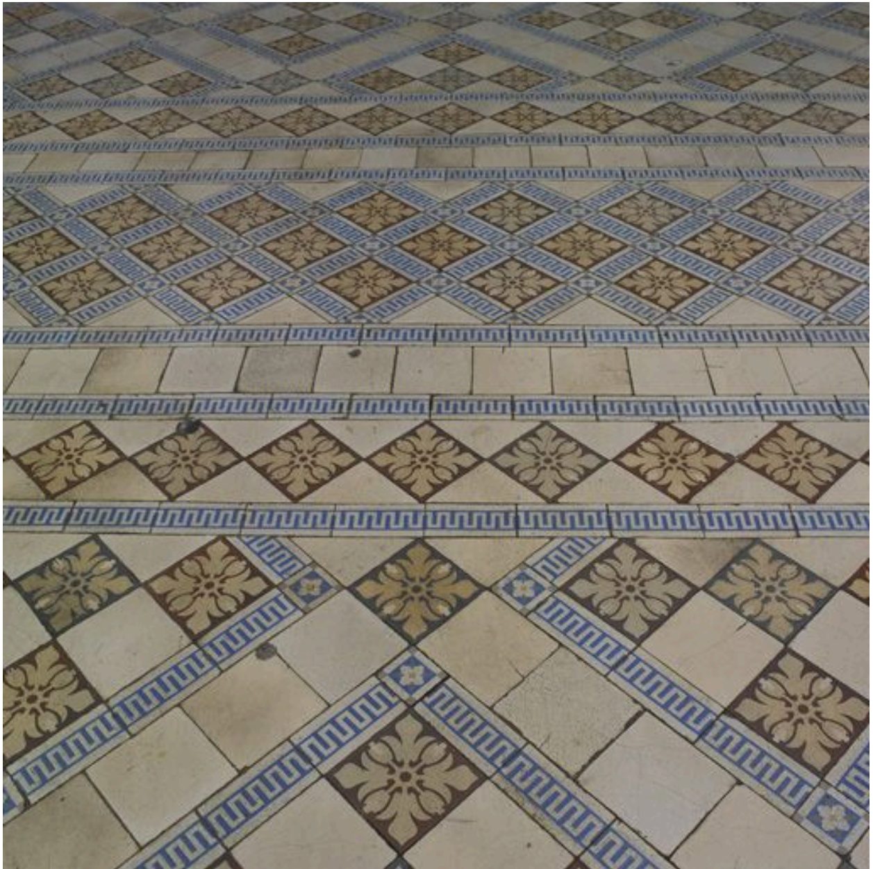
Sous-sol rue de la République : détail du carrelage
