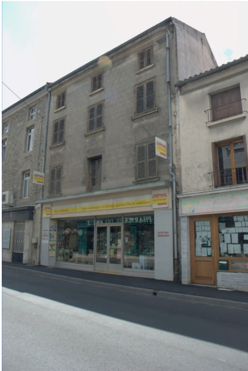
Îlot 5. Clermont (rue de) 60. Vue générale de la façade sur rue.
