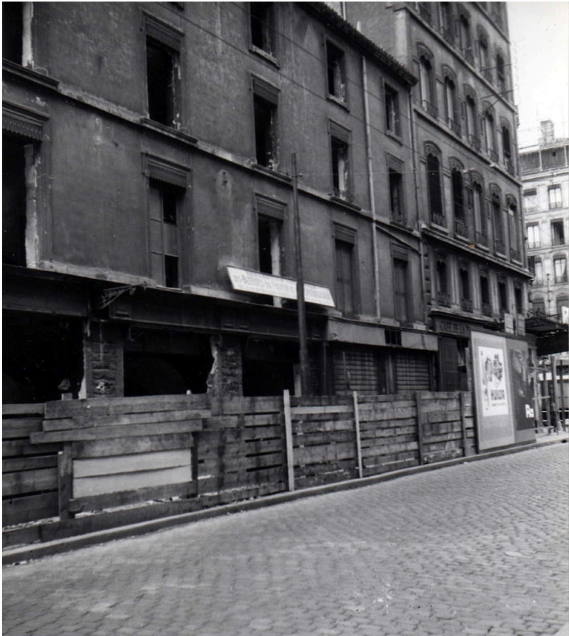
Démolition du passage, élévation sur la rue Childebert : vue partielle
