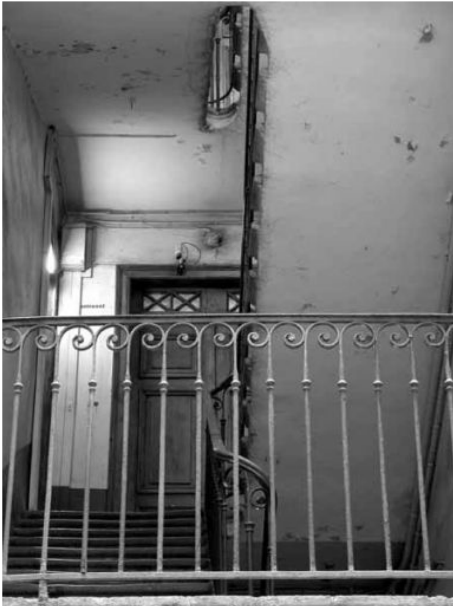
Rez-de-chaussée de l'escalier, vue prise en direction du palier du 1er étage
