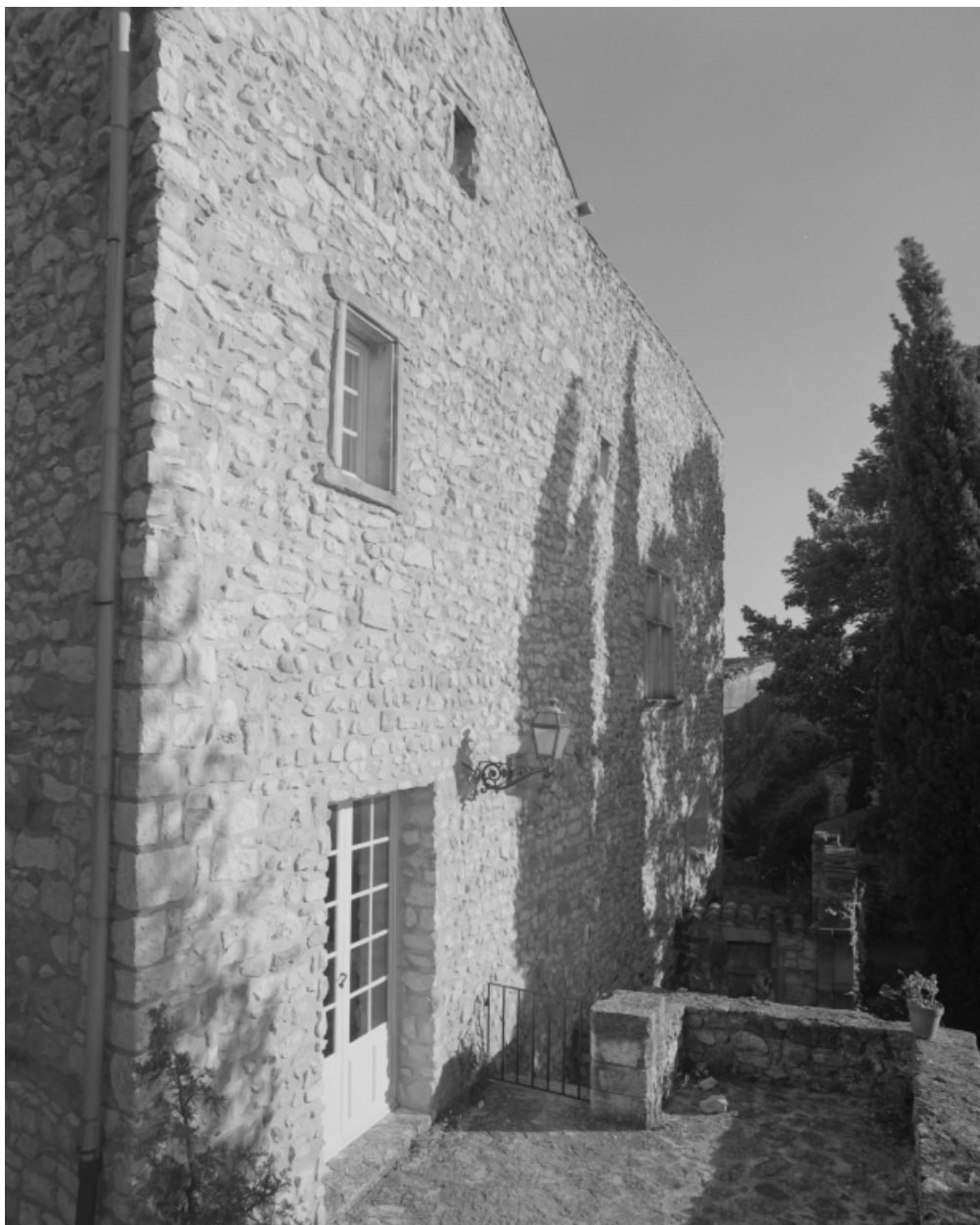
Corps nord-ouest, élévation postérieure.
