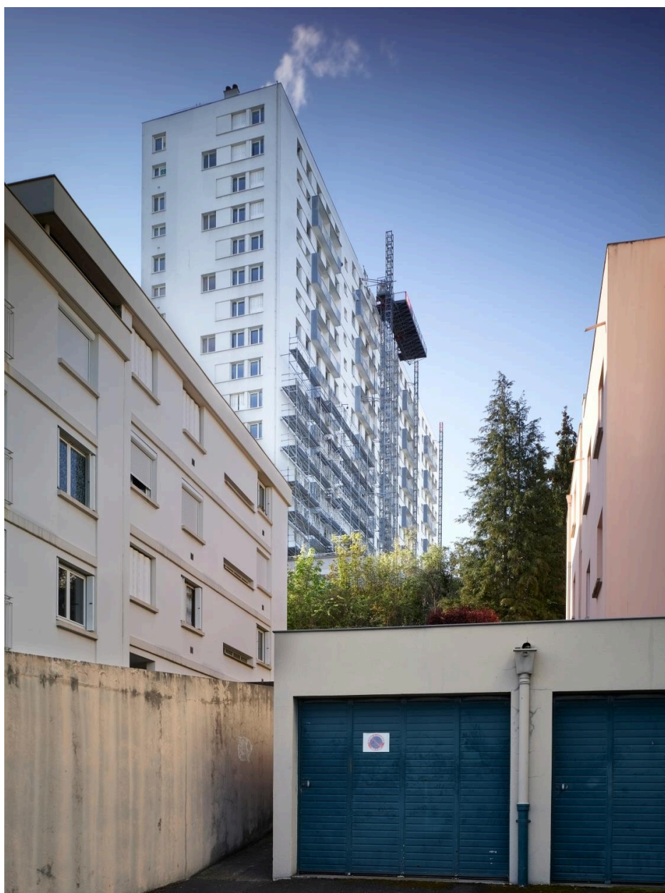
Vues générales des bâtiments du Secteur industrialisé. Immeuble dit Allée des Dômes, en avril 2021 : en cours de déconstruction.
