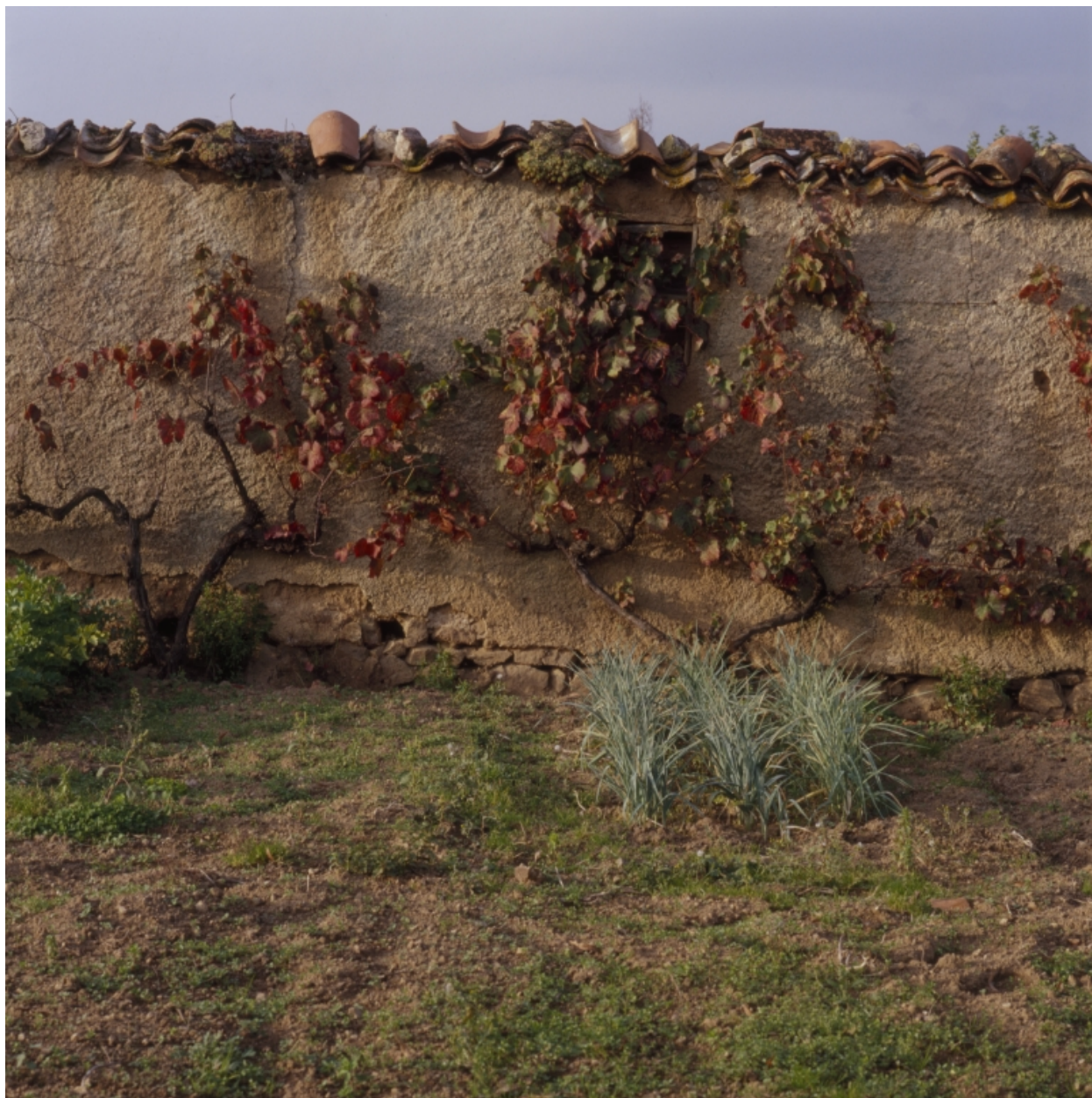
Jardin potager enclos d'un mur de pisé sur lequel grimpent des pieds de vigne (Leigneux, les Junchuns).
