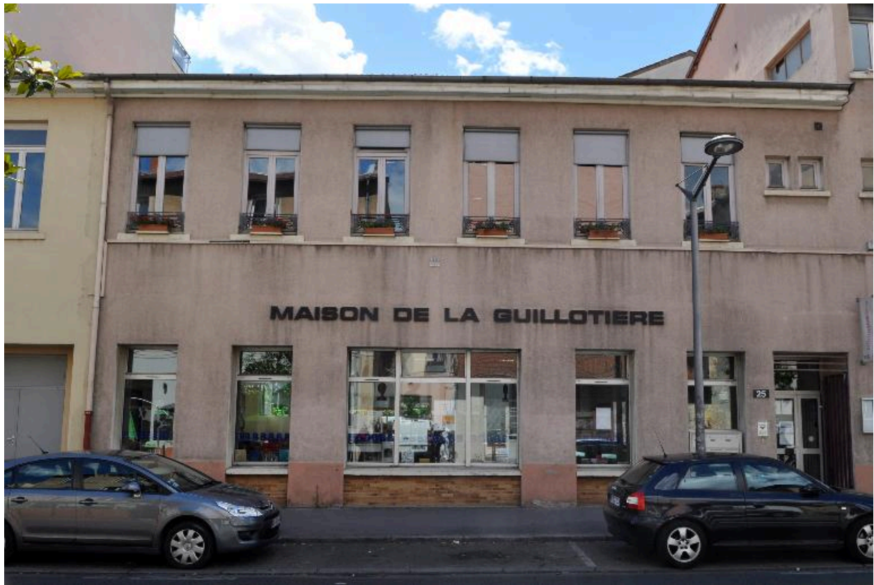
Vue du bâtiment bas au 25, rue Béchevelin
