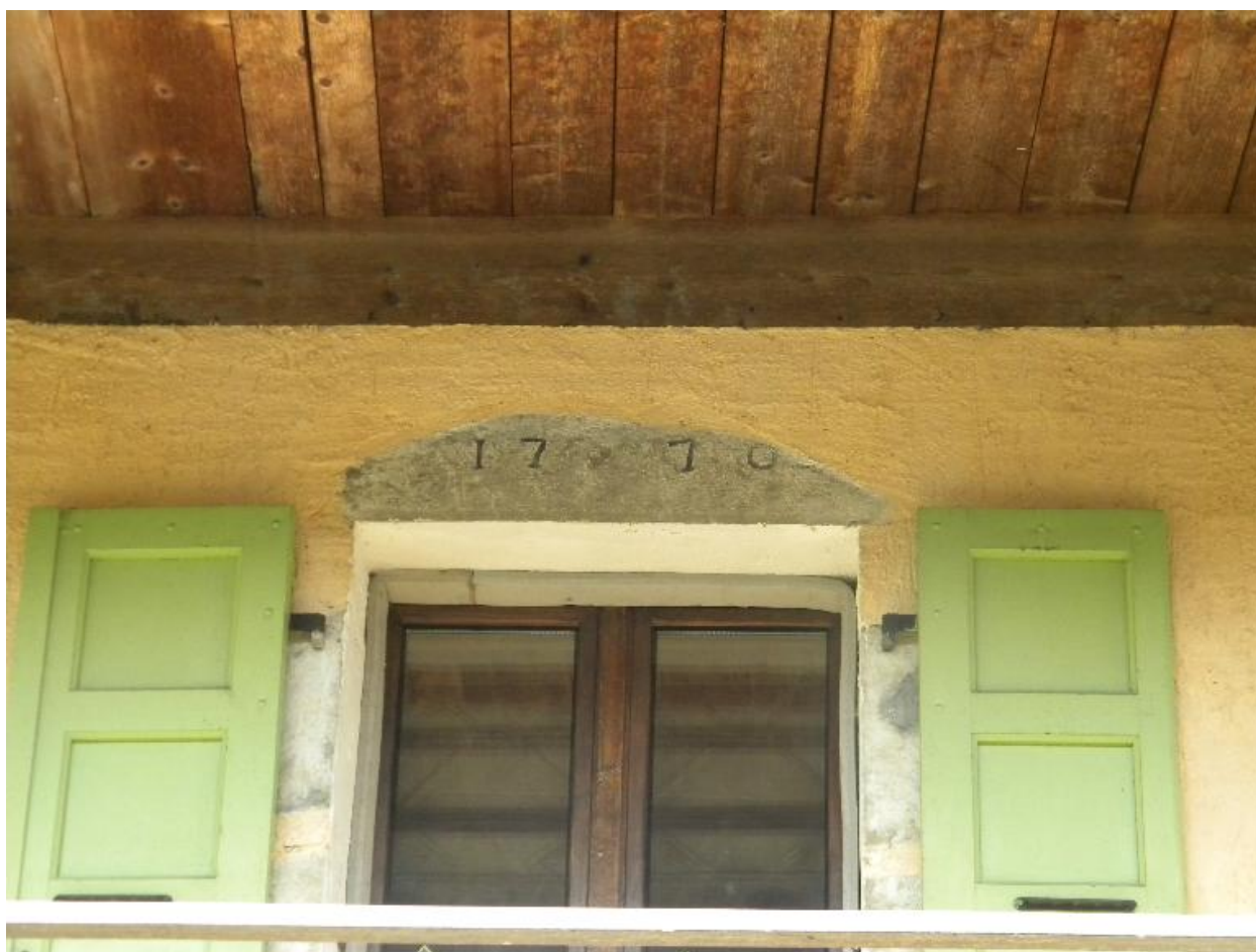
Vue d'un linteau de fenêtre portant la date 1770.
