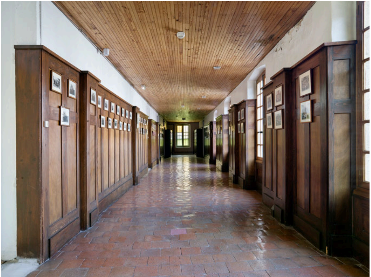
Bâtiment A, 1er étage : vestibule vu depuis l'entrée de la tribune de la chapelle.
