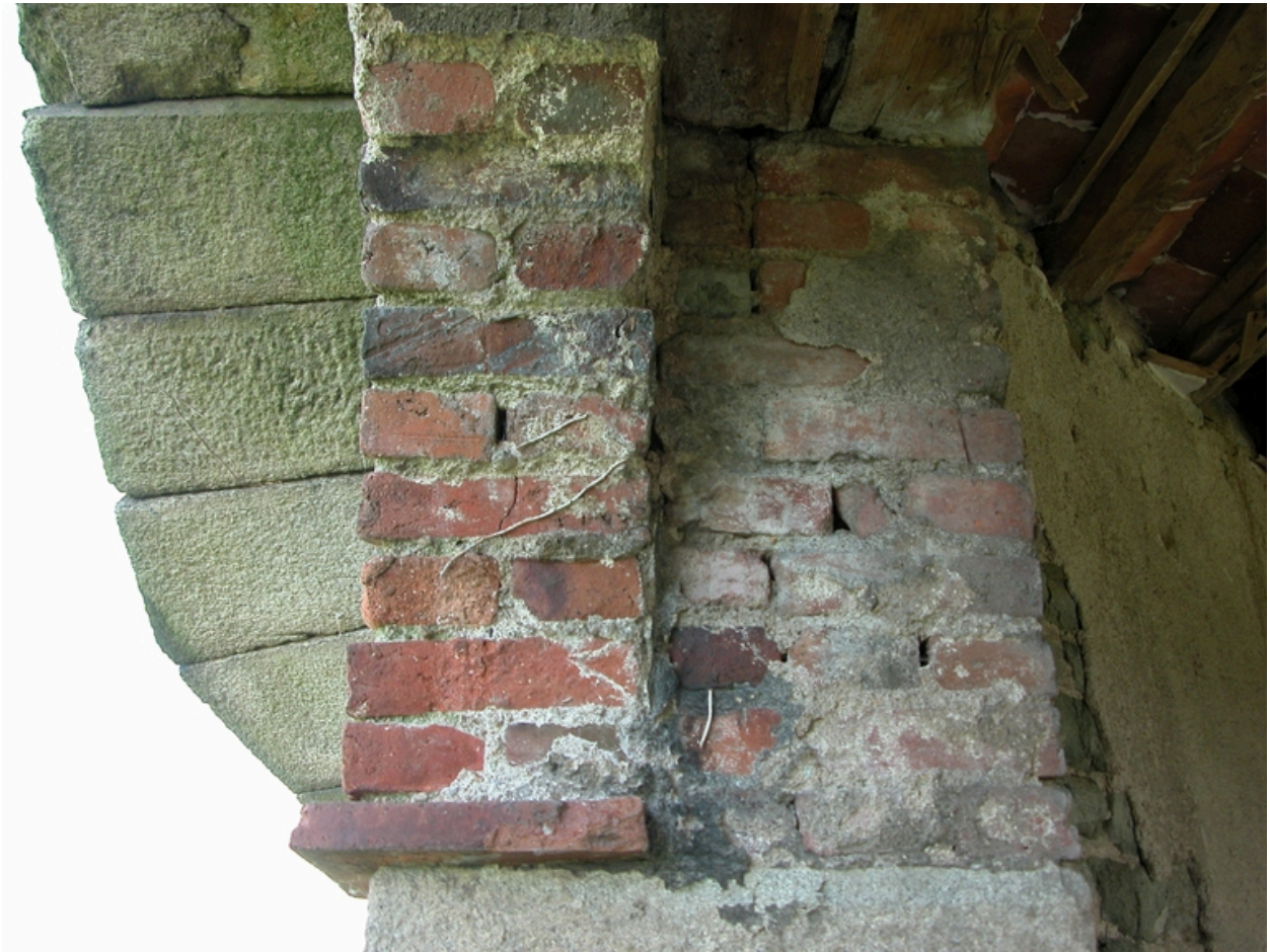
Détail de maçonnerie (arcade, escalier).
