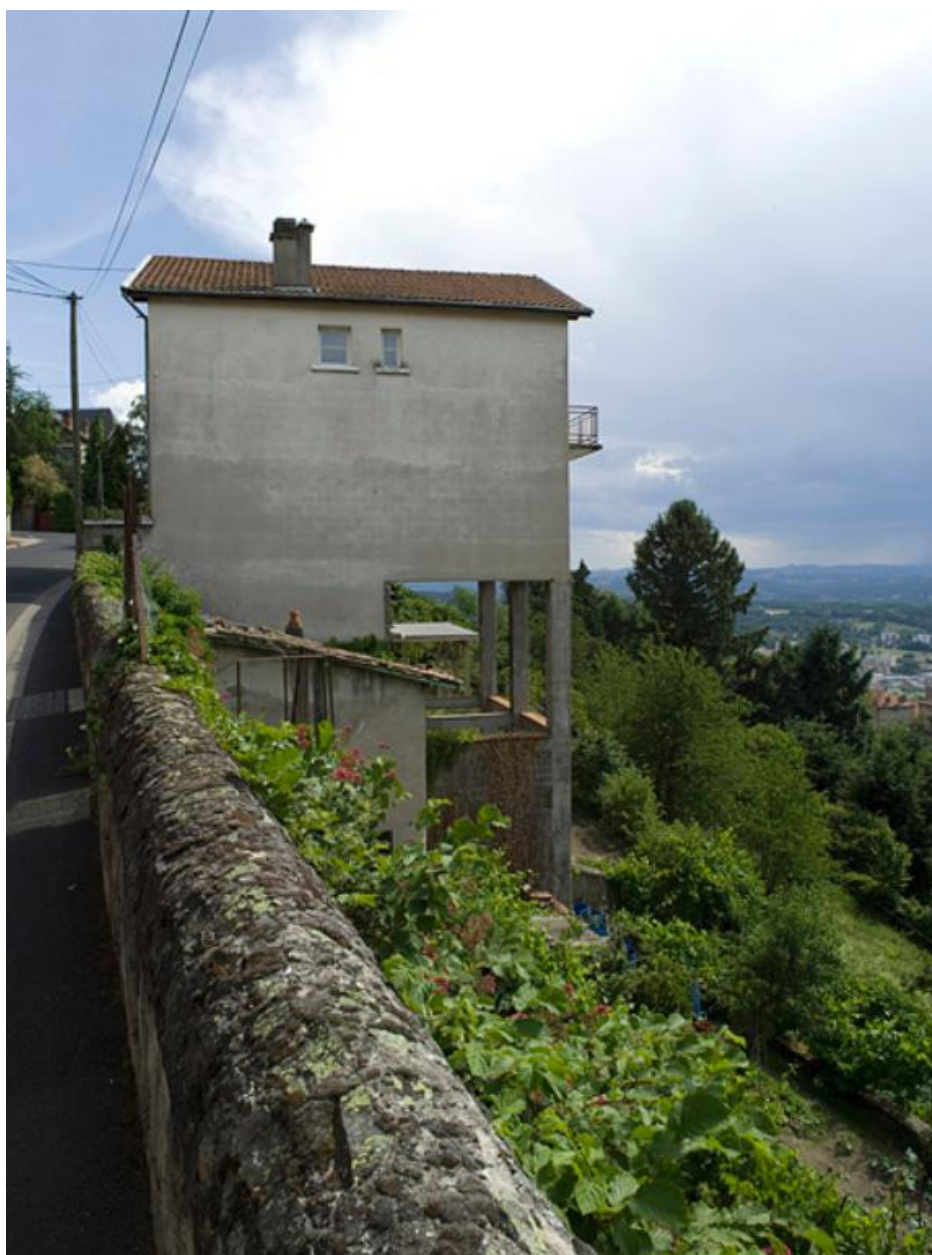
Maison sur pilotis, avenue Etienne-Guillemin.
