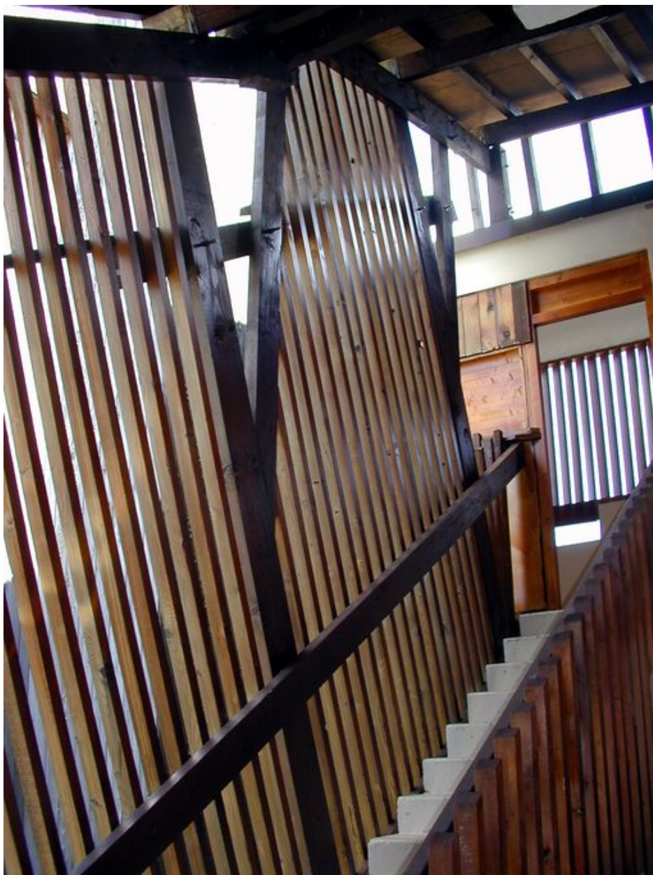
Un garde-corps d'escalier
