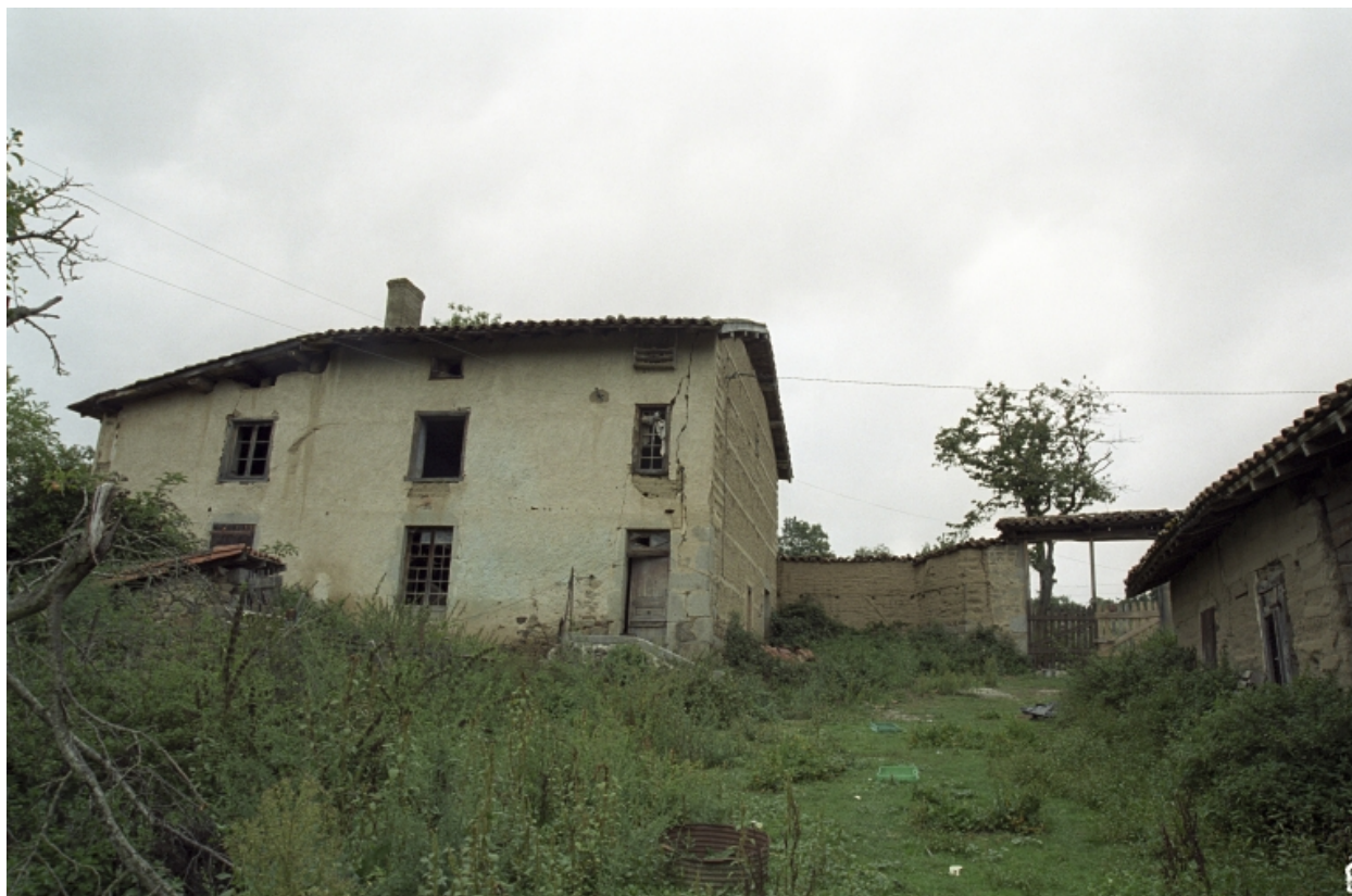
Vue d'ensemble du logis depuis la cour, du sud.
