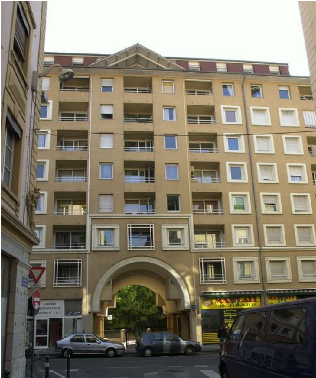
Travée centrale et passage couvert d'entrée
