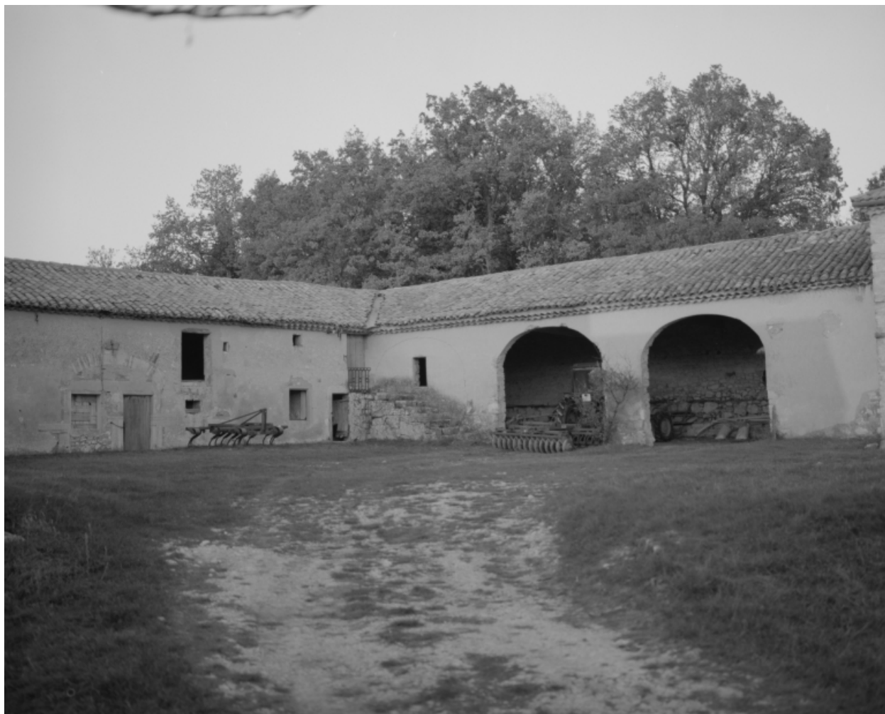
Une partie des dépendances de la ferme.
