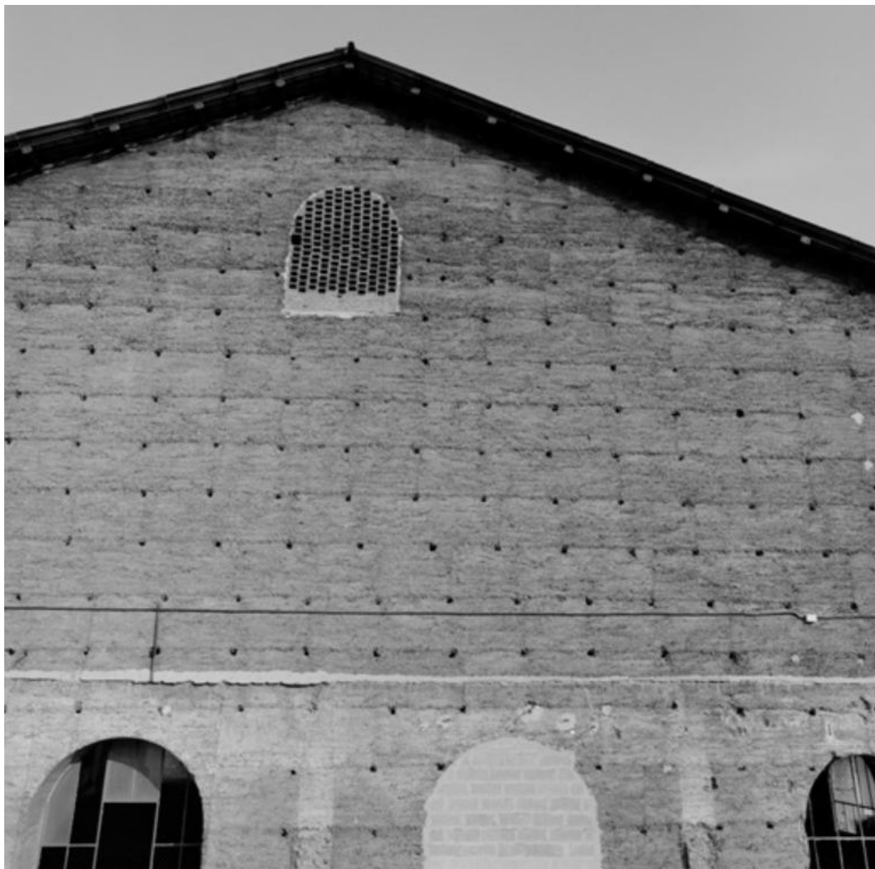
Détail bâtiment de stockage : aérateur en brique
