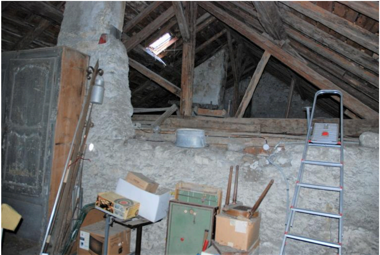
Etage de comble, vue en direction du nord. Vue d'ensemble du massif abritant les chambres du premier étage situées au nord. Vue d'ensemble de la charpente.
