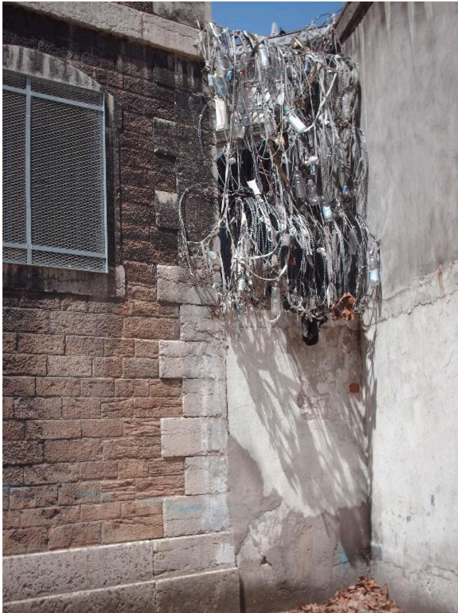
Etat en 2010 : cour de promenade, détail des matériaux et yoyos
