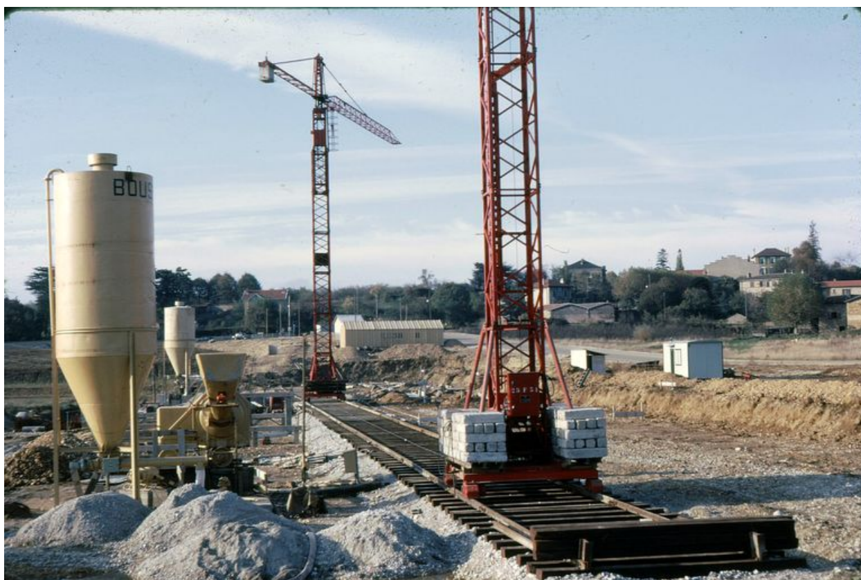
Chantier du quartier de la Sauvegarde, 1er novembre 1961
