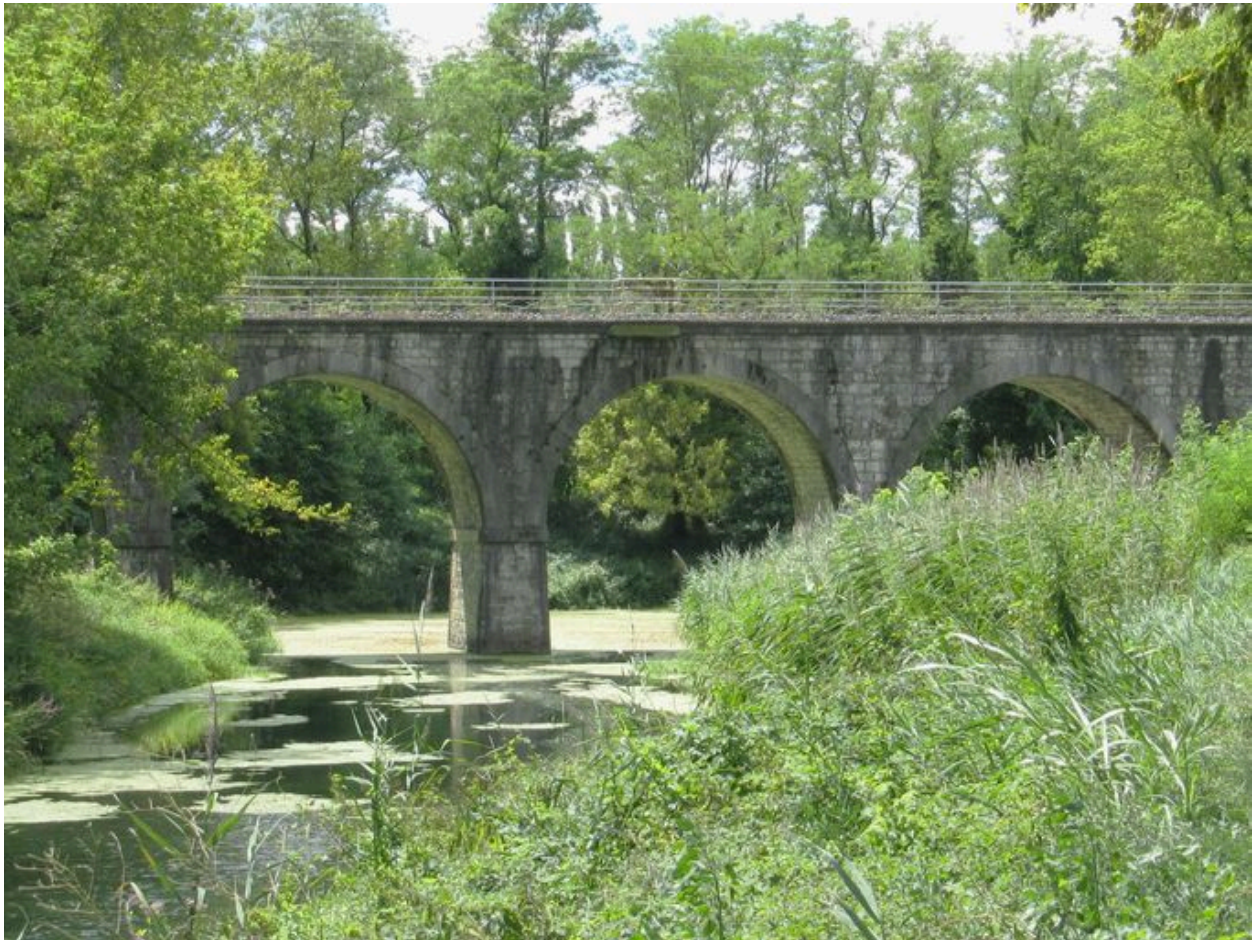
Vue générale, face amont (partie franchissant le Petit Rhône)
