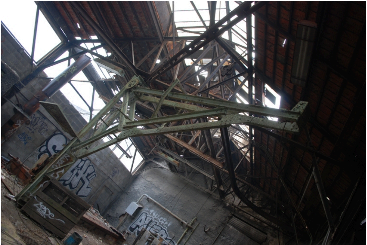
Vue intérieure : charpente métallique et lanterneau
